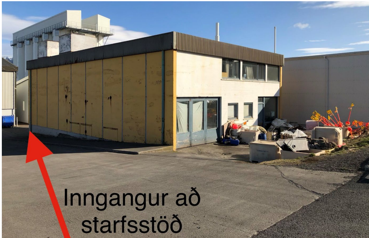
Mynd 2.2 Hafnarbyggð 16 í dag séð frá götunni, aftan við húsið er aðkoma að starfsmannainngangi og geymslu.
