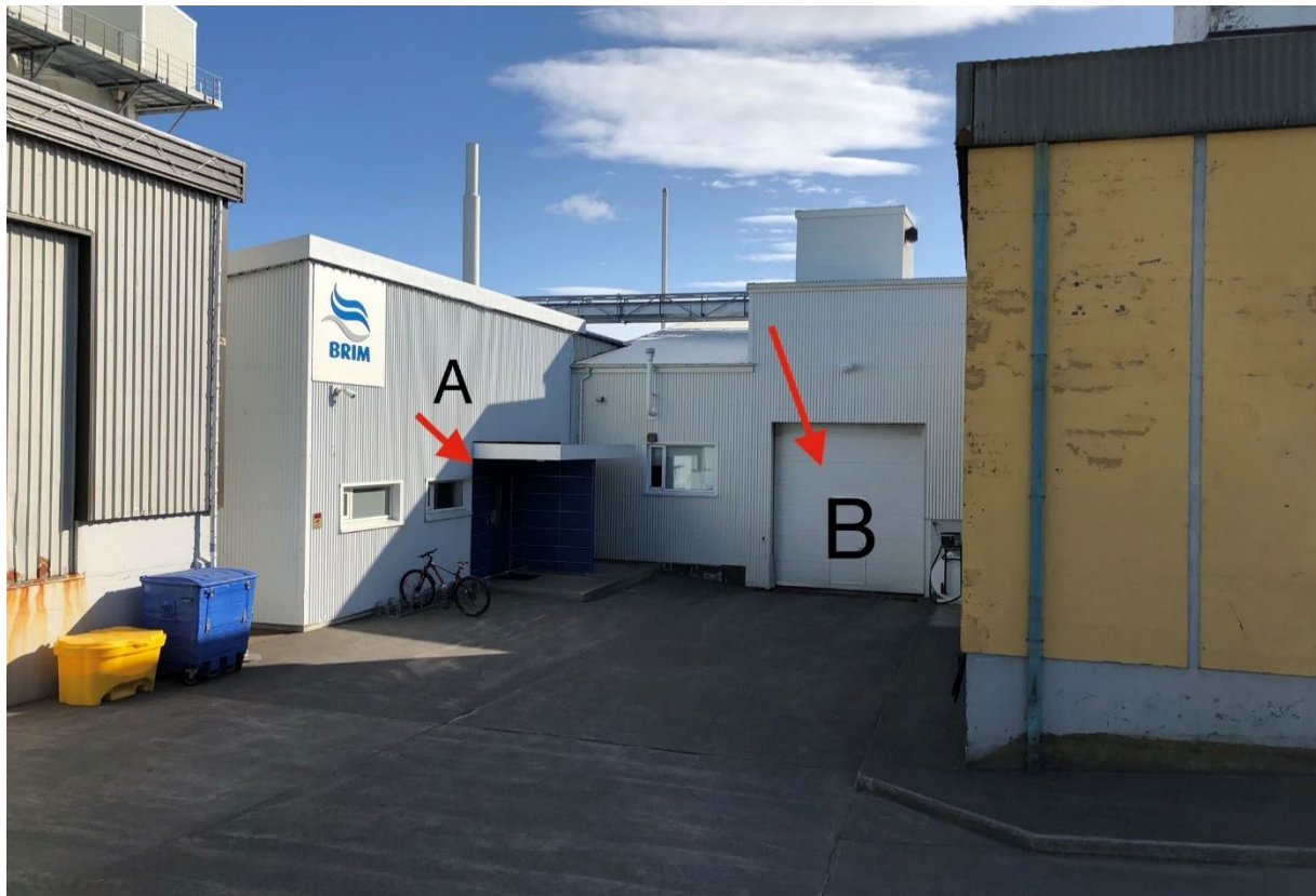
Mynd 2.3 Horft inn í húsasundið bakvið Hafnarbyggð 16 (gult hús til hægri á mynd). Búið er að merkja inn á myndina starfsmannainngang (A) og inngang í geymslu (B).
